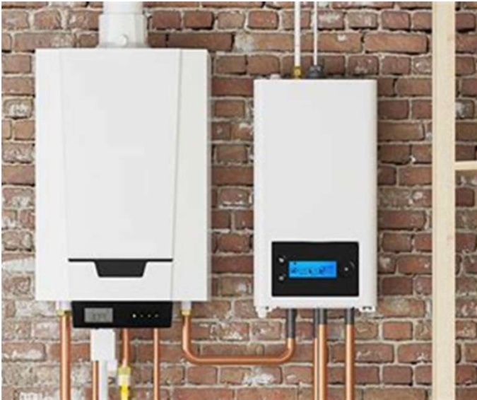
Hybride warmtepomp op bestaande cv-ketel
