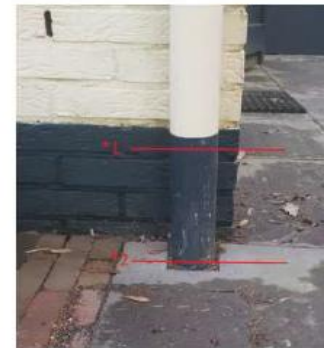
Foto 1: HWA afvoer voor aanbrengen HA-steen met de zaaghoogtes ter indicatie aangegeven.
